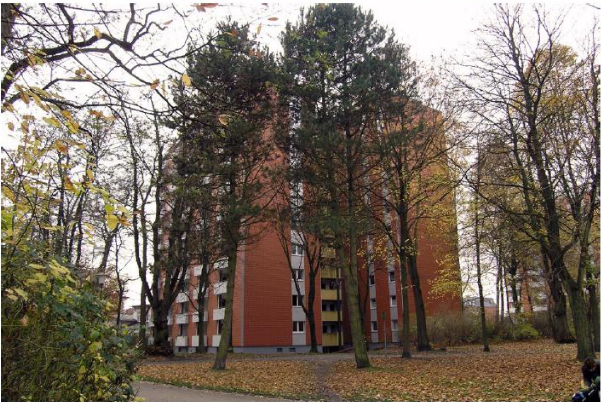
Foto 6 Die Pflanzung schirmt heute den Parkraum zu der mehrgeschossigen Wohnbebauung ab
