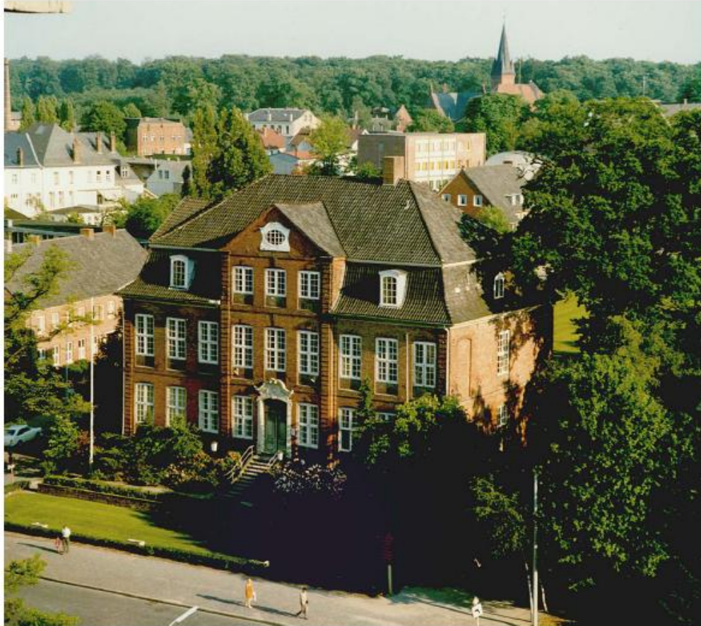
Abb. 8: Eingangsbereich vor dem Drosteigebäude mit seitlicher Erschließung der Sandsteinmauern und Pflanzungen aus Rhododendron und Koniferen.
