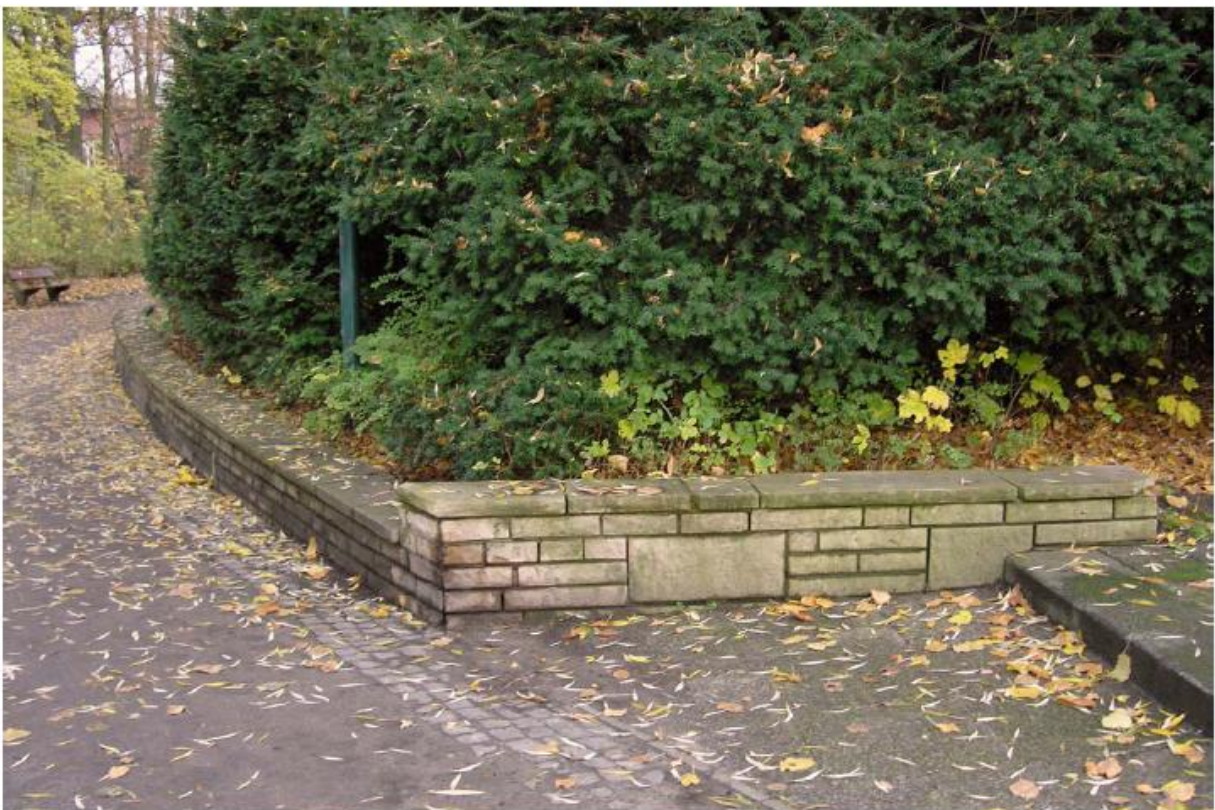
Foto 11e Einfassungsmauern aus Thüster-Kalkstein, ein Ausstattungselement, das in Hinblick auf die IGA 1973 in Hamburg vorgeschlagen und realisiert wurde
